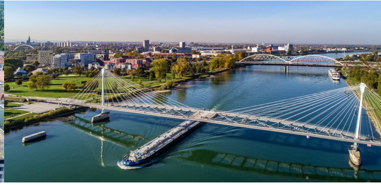
Passerelle des deux Rives
